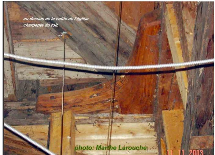
Photo de la charpente de la toiture dans les coins : racines de pin blanc. Les poutres du toit mesurent 30 cm par 30 cm équerries à la hache.
